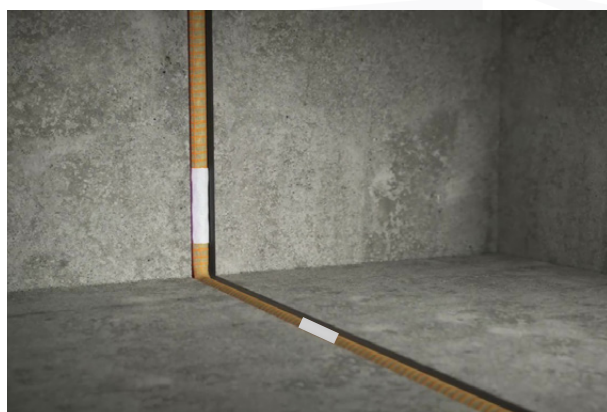
Traitement de joints de sols et de murs avec raccords.
